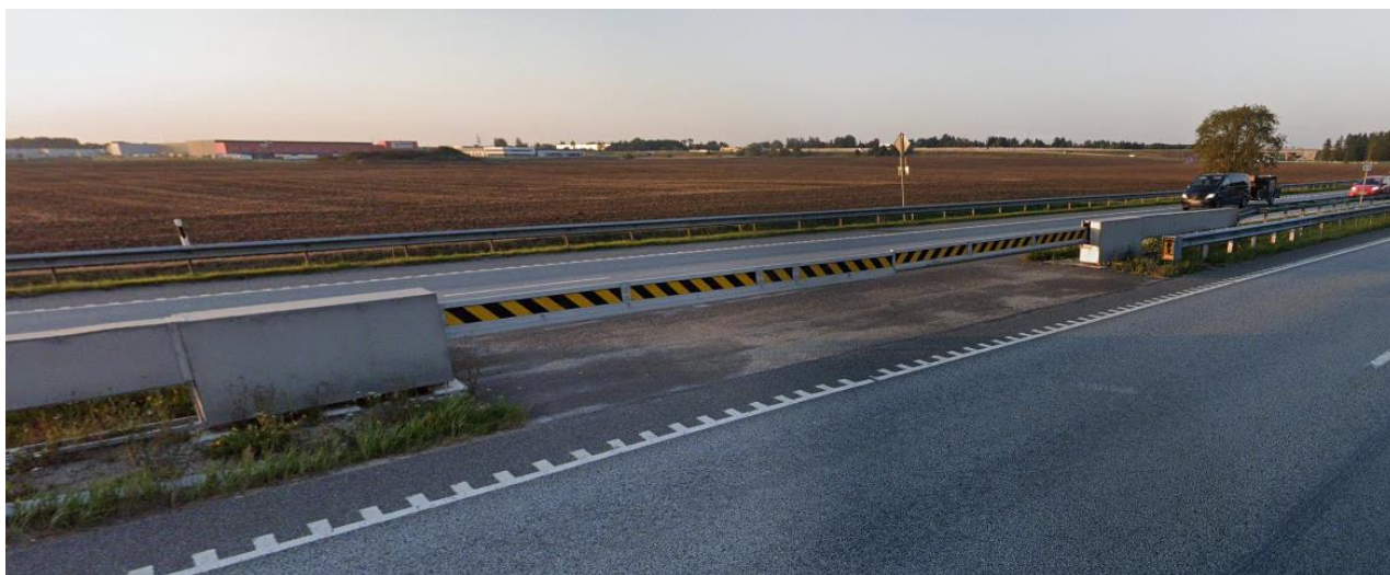
Pilt 10. Liugpoomide kasutamise näide Tallinna ringteel (illustratiivne pilt)
