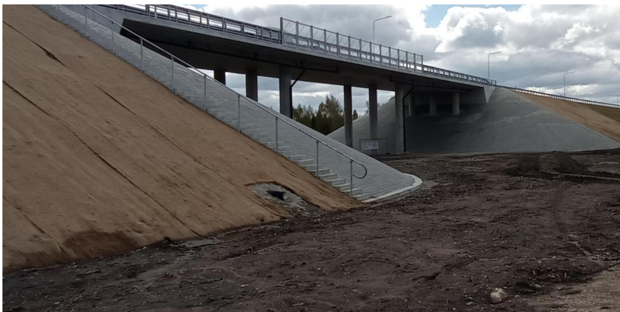
Pilt 3. Vihmaveetorude otste kindlustamine
