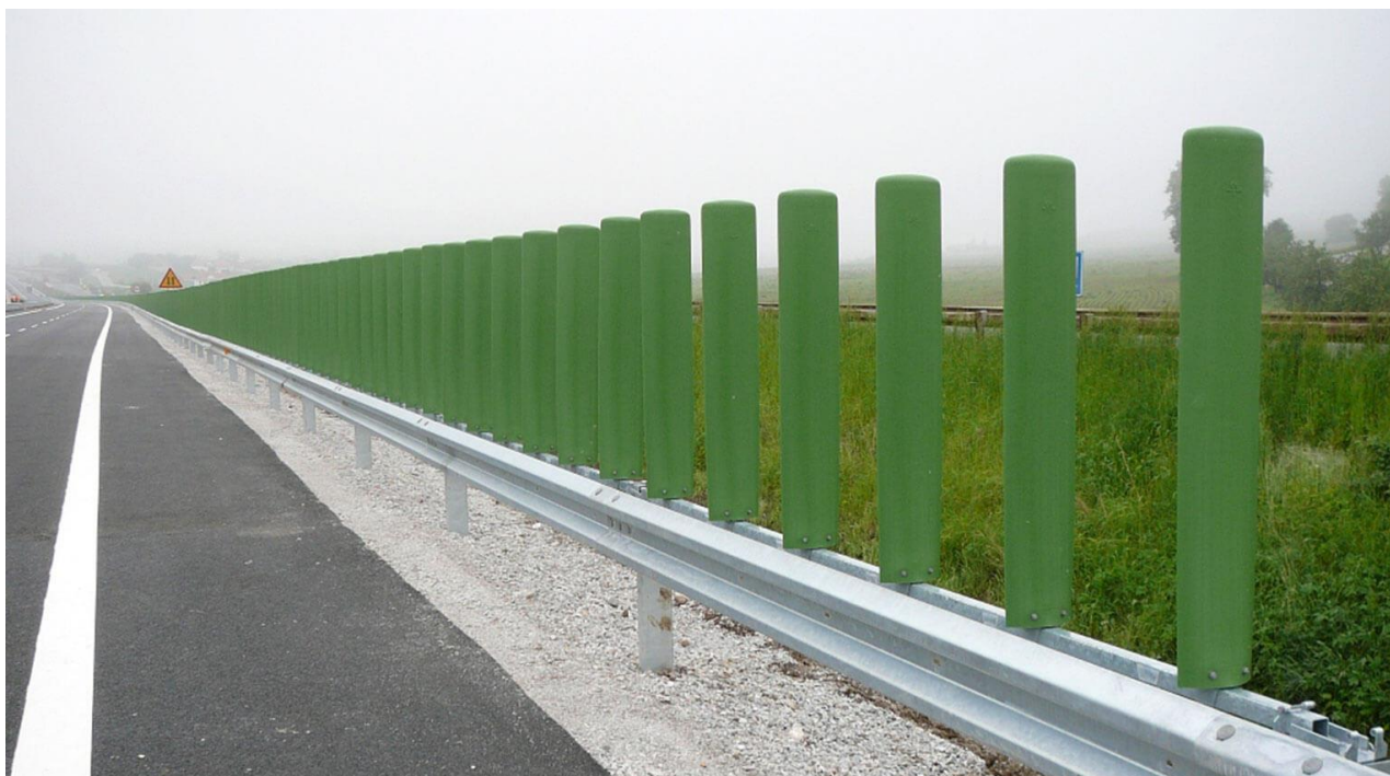
Pilt 7. Pimestamisvastased ekraanid
